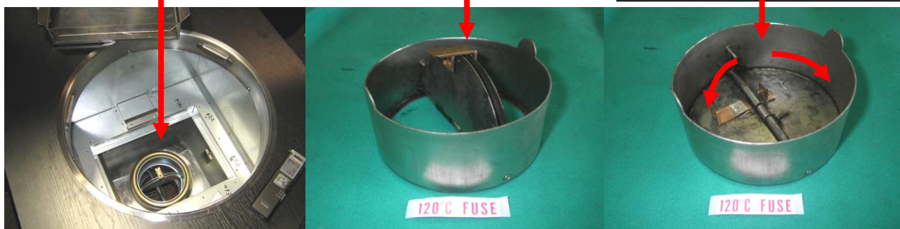
温度ヒューズが溶断すると、バネの力でダンパの羽根が開く
